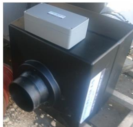
Sensor monteret på filterhus, 100 m 3 /t luftafkast
